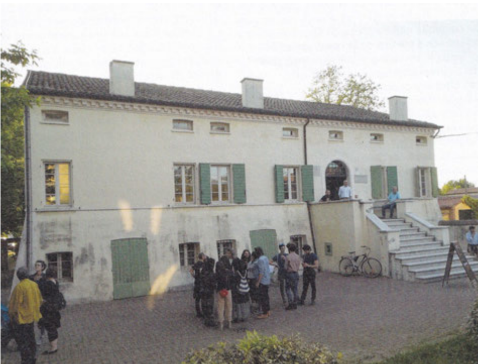
Figg. 5-6) - Stellata Casa Ariosto, prima e dopo il restauro.
